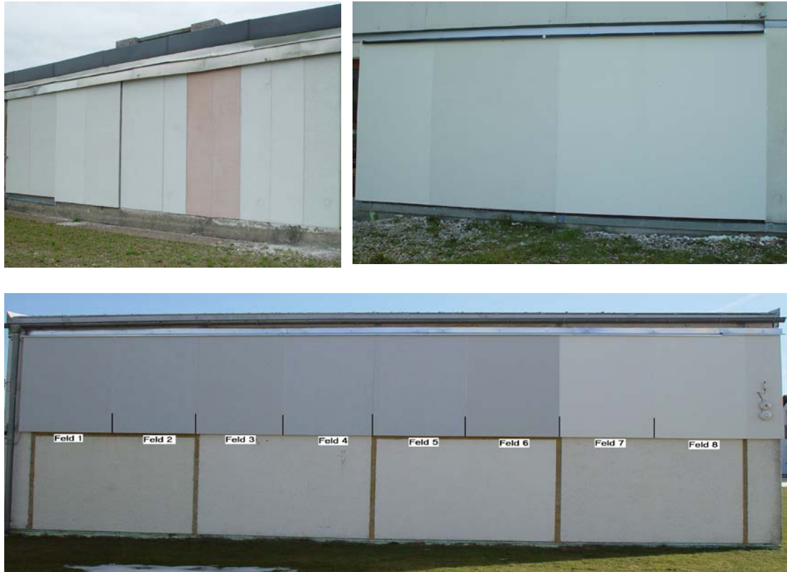
Abbildung 22. Fotografische Ansicht der westorientierten (links oben) und der nördlich orientierten Fassade (rechts oben und unten).
