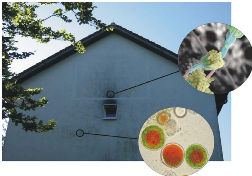
Abbildung 1: Wachstum von Algen auf einer Fassade mit dem Wärmedämmverbundsystem (WDVS) und Pilzwachstum über dem Fenster.
