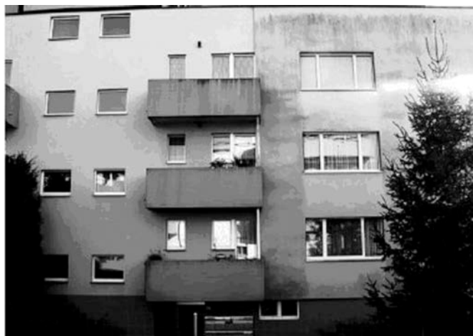
Abbildung 2: Fotografische Ansicht von einem Gebäude, auf dem die rechte Seite ungefähr ein Jahr vorher gedämmt wurde. Der höhere
