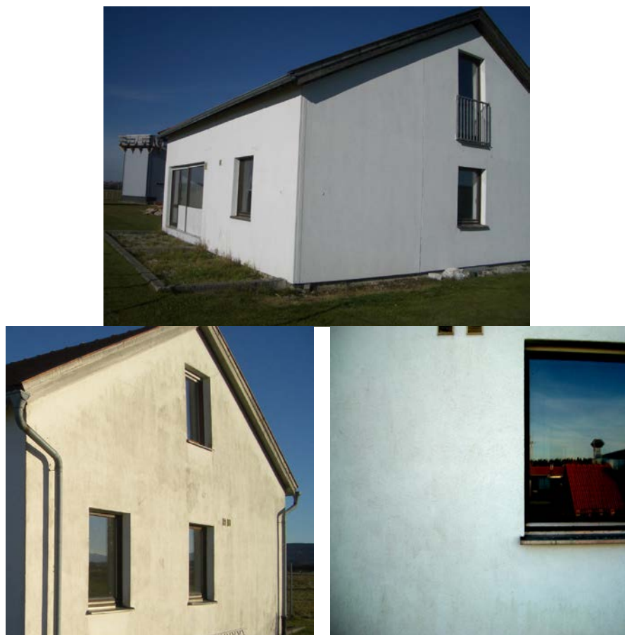
Abbildung 6: Fotografische Ansichten der unterschiedlichen Orientierungen eines Gebäudes auf dem Freigelände des IBP. Die Ost- und Südseite (oben) sind weitgehend bewuchsfrei. An der West- und Ostseite (unten links und rechts) ist deutlicher Bewuchs zu erkennen.
